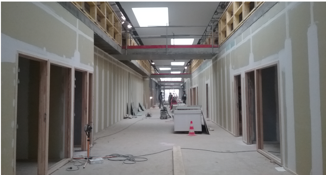
Le rez-de-chaussée et une passerelle du premier étage
