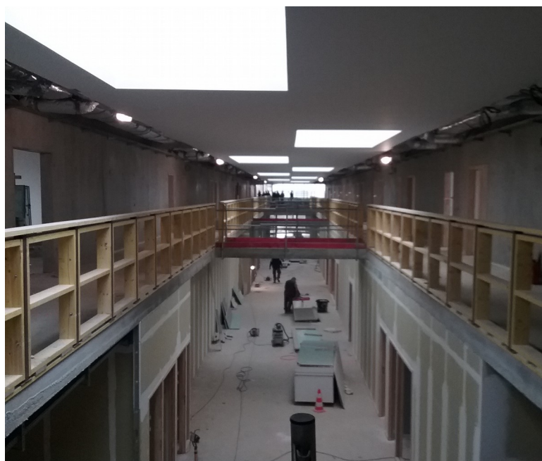
Les couloirs latéraux et les passerelles
